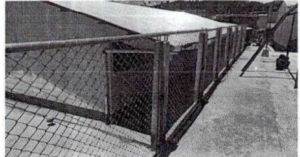
Foto 2: SUSTITUCION DE MAYA GALVANIZADA
